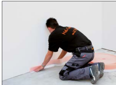
2 Einbau des Randstreifens BRS 808 KSF mit Klebestützfuß.
