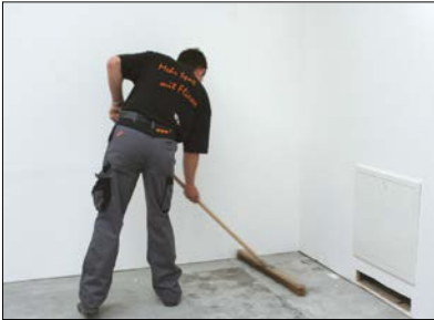
1 Reinigen des ausreichend tragfähigen und ebenflächigen Untergrundes.
