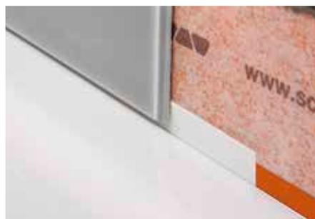
Schlüter-KERDI-CP est une protection anti-coupure pouvant être raccourcie et permettant de protéger le niveau d'étanchéité lors du renouvellement ultérieur du joint en silicone. Le profilé pliable utilisable seul peut être directement monté dans le lit de colle ou sur Schlüter-KERDI-FIX venant d'être posé. (Fiche produit 8.9)
