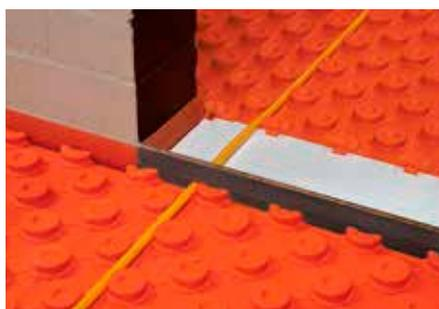
Schlüter-DILEX-DFP est un profilé de mouvement destiné au fractionnement des chapes, au niveau des passages de portes.
