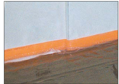
3 Einbau des Randstreifens BRS 810 oder BRSK 810 bei erdfuchtem Estrich. Bei Fließestrich sind die Randstreifen BRS 808 KF oder BRS 808 KSF mit Klebefuß zu verwenden.
