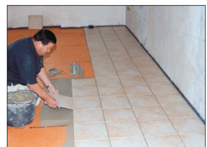
12 Verlegung des Fliesenbelags auf DITRA in Dünnbettmörtel.
